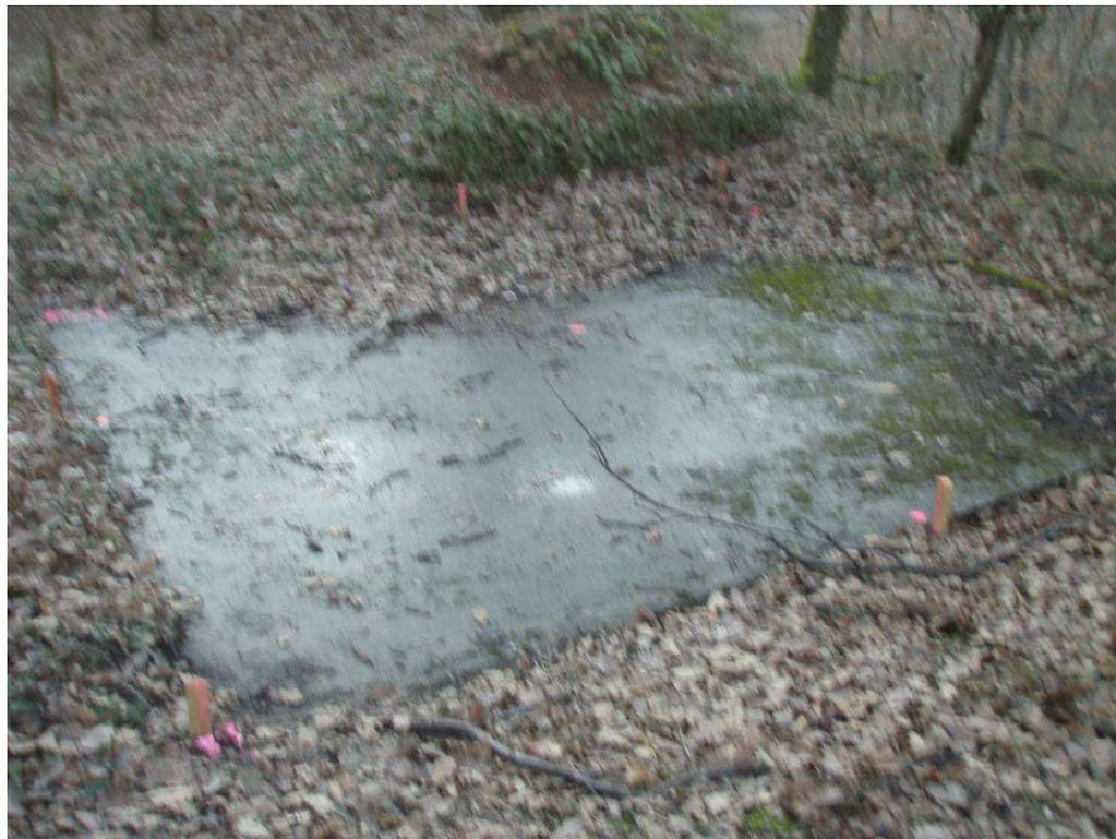
*Photo 2 : dalle béton sur la tête du puits Henry
