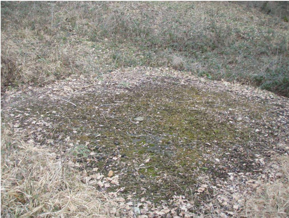
*Photo 4 : dalle béton sur la tête du puits Brachet Sud
