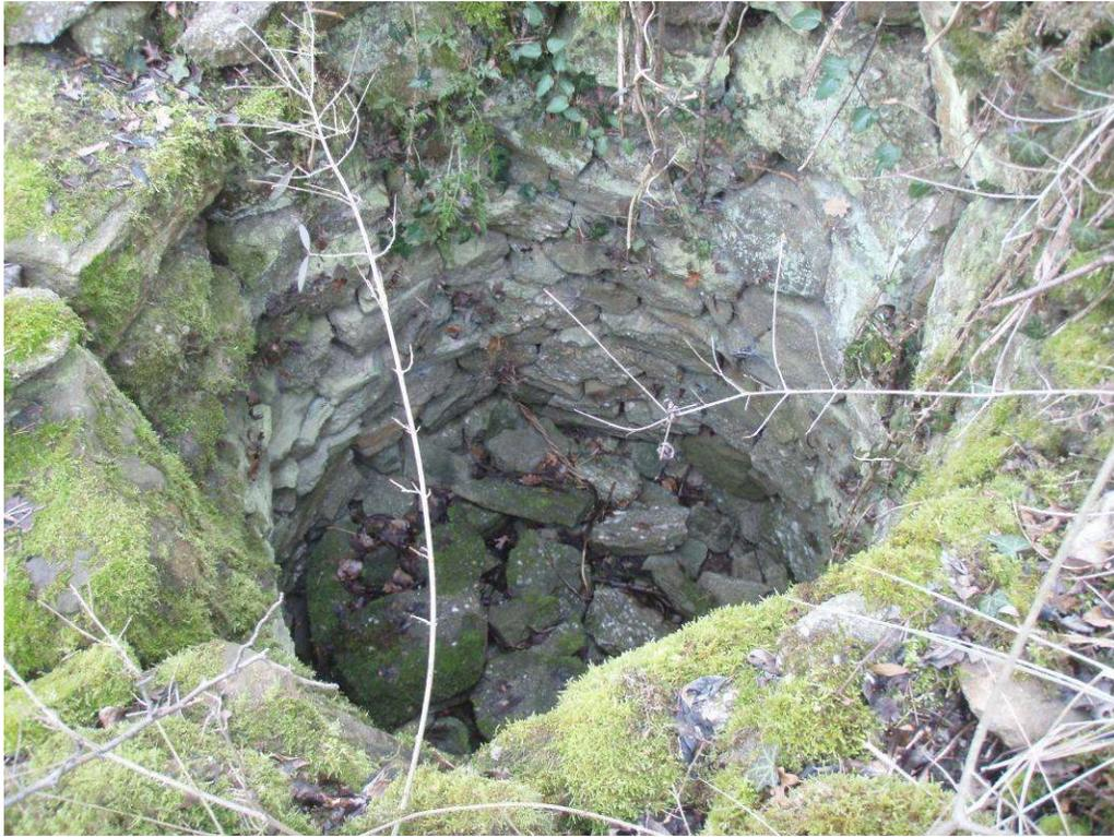
*Photo 3 : cuvelage en pierres sèches du puits de Noailly
