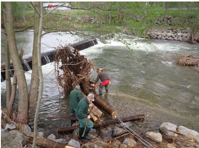
La même levée pendant les travaux de nettoyage
