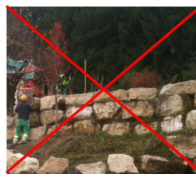
exemple de mur cyclopéen
