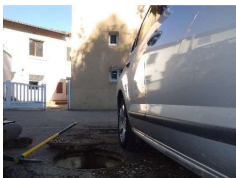
DO3 (vue extérieure)
