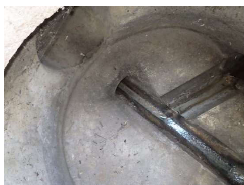
DO3 (vue intérieure)
