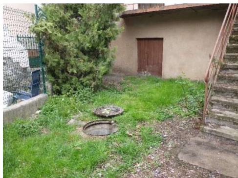
DO2 (vue extérieure)
