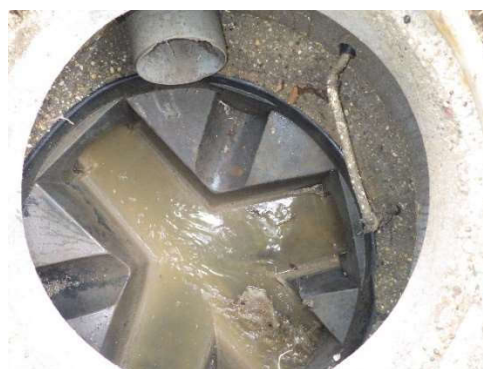
DO5 (vue intérieure)
