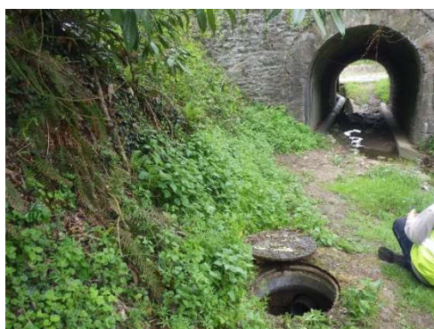
DO5 (vue extérieure)
