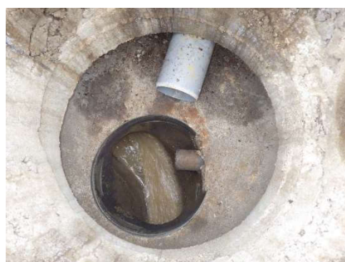
DO6 (vue intérieure)
