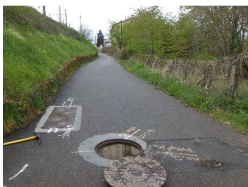
DO6 (vue extérieure)
