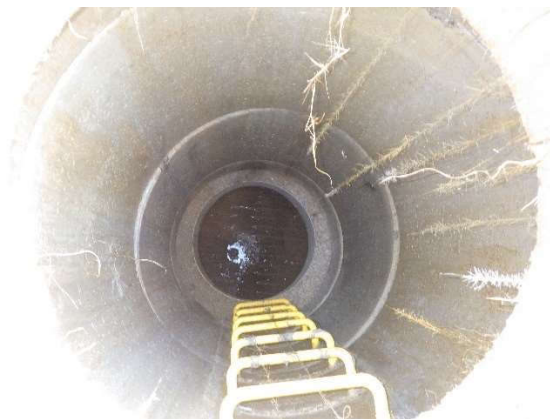
Vue intérieure (regard d'entrée)
