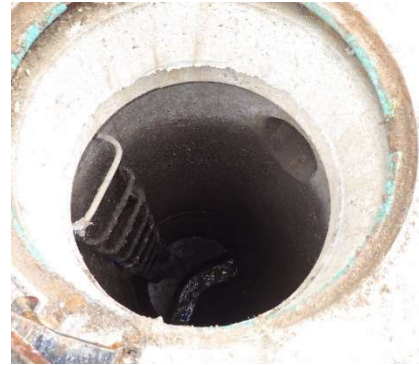
DO7 (vue intérieure)
