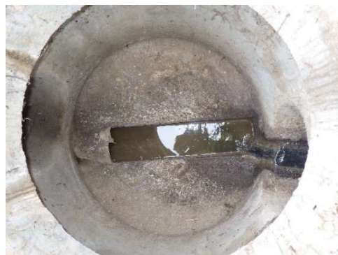
DO2 (vue intérieure)
