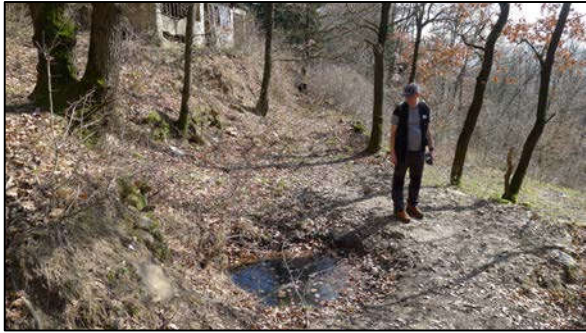
Cuvette de tassement sur le puits PERRAULT
