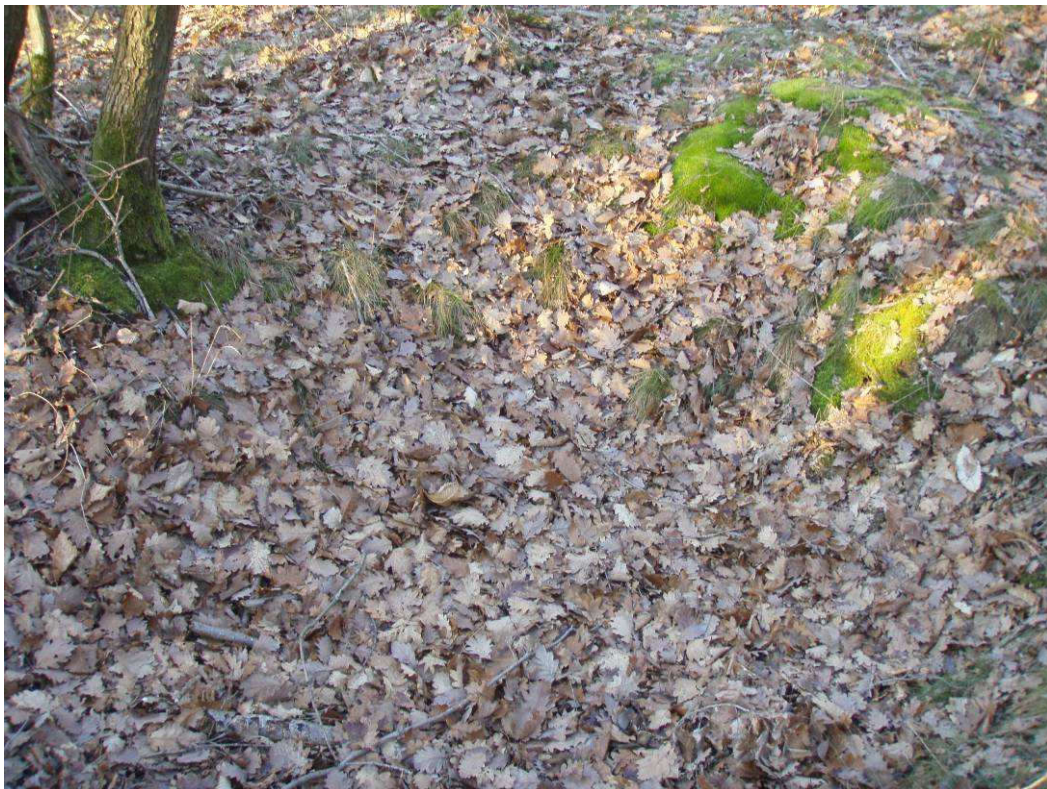
Photo 15 : fontis du puits d'Aérage Henry N°2 (concession de La Forestière et Fontanas).
