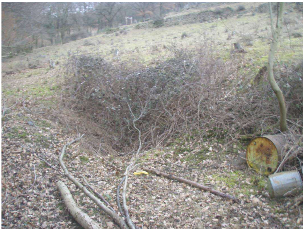
Photo 7 : emplacement de la galerie de Combe-Charbonnière (concession de Givors et Saint-Martin de Cornas).
