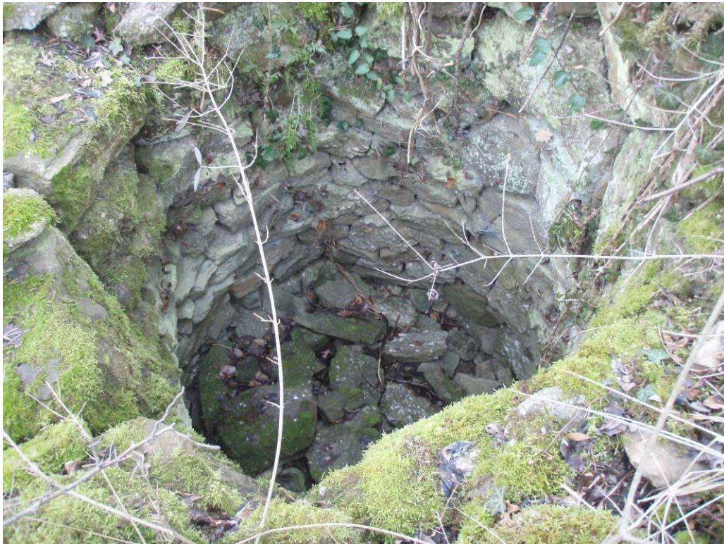
Photo 3 : cuvelage en pierres sèches du puits de Noailly (concession de Givors et Saint-Martin de Cornas).
