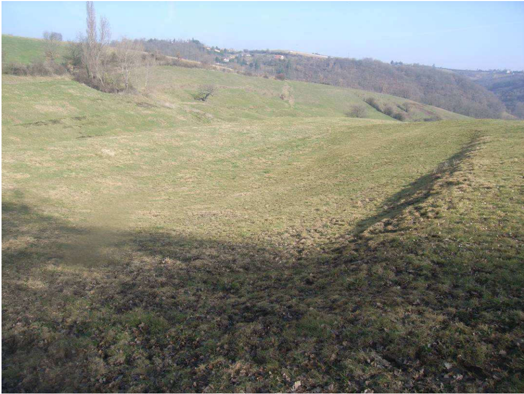
Photo 13 : autre vue du glissement des travaux du puits Gabriel (concession de Tartaras et Dargoire).
