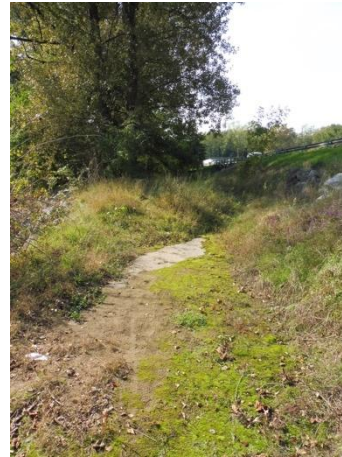
Reste de la route détruite par la crue de 2008 (©CESAME)
