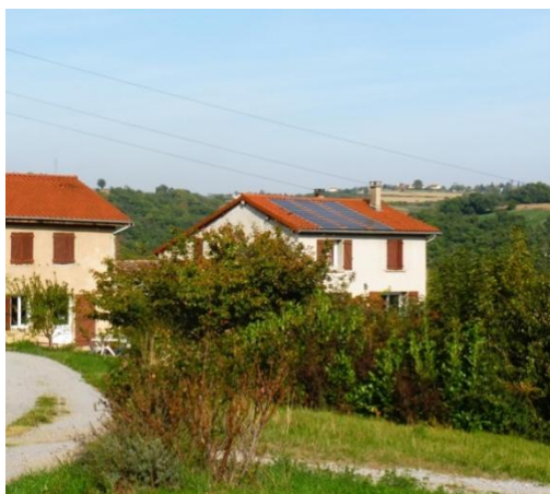
Installation de panneaux solaires (©CESAME)
