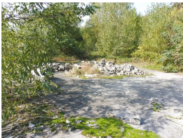
Ruine du bâtiment emporté par une crue du Gier (©CESAME)
