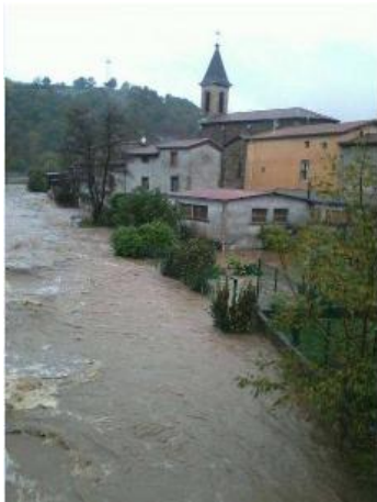
Saint-Romain-en-Gier durant la crue de 2008 (source : PAPI)
